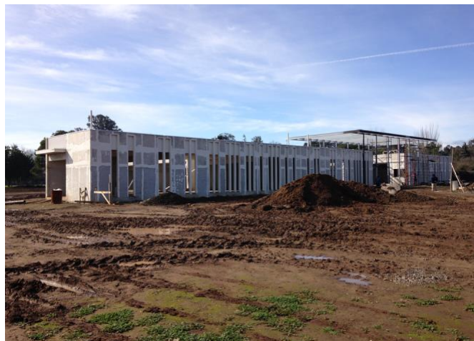
Construcción primera etapa Colegio Talca 2015
